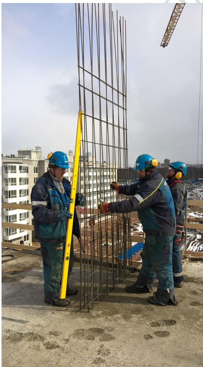
Рис. 2. Установка сеток в проектное положение. Мастер контролирует вертикальность установки сеток.
