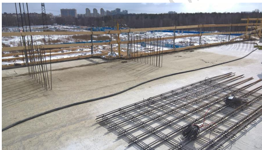
Рис.1. Комплект для армирования простенка, состоящий из сеток и скобо-гибочных изделий (“пэшек”) на перекрытии (слева на фото видны выпуски арматуры простенков).
